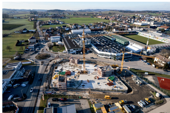
Bereits Mitte Februar 2022 wird mit dem Holzbau begon-nen. Fertigstellung der TEAM 7 Welt ist für April 2023 geplant.
